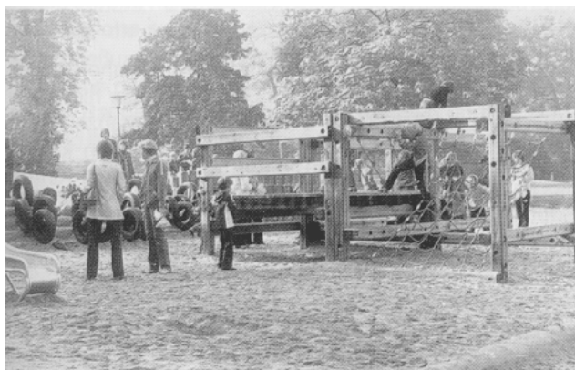
Фото 5. Приспособления для игр детей, монтируемые из полностью готовых деревянных деталей, быстро строятся, демонтируются и перестраиваются с одновременной заменой поврежденных частей. Устойчивость обеспечивается соединением узлов специальными крепежами. (Открытие и патент: Scheel и Taurit)
