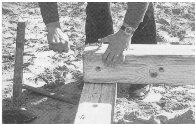
Фото 5. Приспособления для игр детей, монтируемые из полностью готовых деревянных деталей, быстро строятся, демонтируются и перестраиваются с одновременной заменой поврежденных частей. Устойчивость обеспечивается соединением узлов специальными крепежами. (Открытие и патент: Scheel и Taurit)
